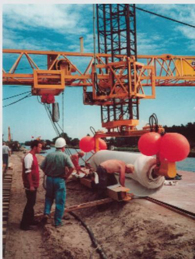
En cooperación con la empresa "e-on Wasserkraft GmbH" más de 1.5 km de fibra óptica fueron tendidos debajo de la capa impermeable en la suela del canal "Mittlere Isar" de una central hidroeléctrica. Esta mundialmente primera aplicación en la construcción hidráulica ya es rutinaria.
